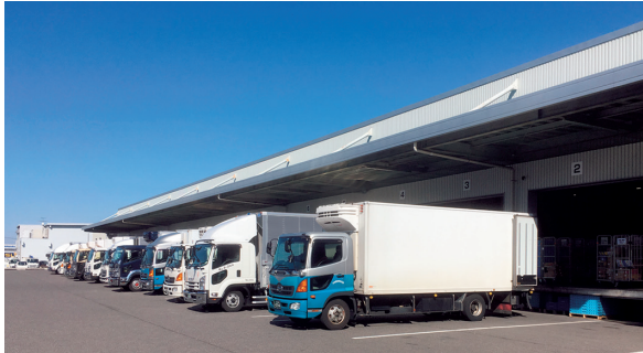
松本第2 常温センター（外観）
